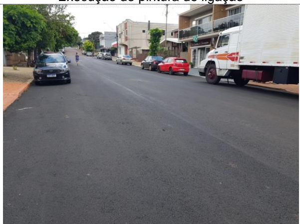
Recape asfáltico
