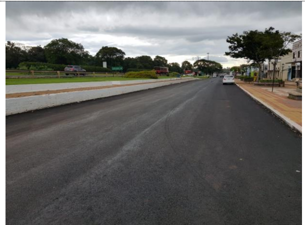
Recape asfáltico
